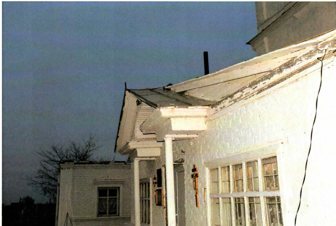
Фото 2. Наружная стена притвора из белого керамического кирпича без оштукатуривания фасадной поверхности
